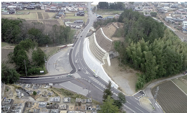
整備が完了した喜多バイパス
