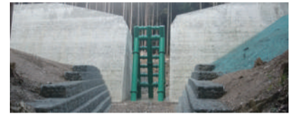
大雨で効果を発揮した砂防ダム
