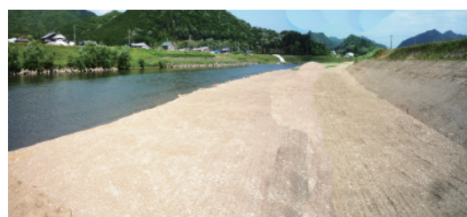
河床掘削 加古川（西脇市蒲江地区）
