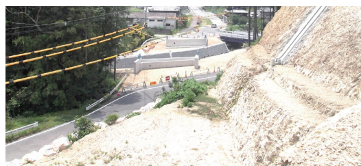
道路改良 黒田庄多井田線 喜多バイパス
