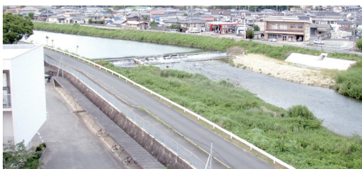
井堰改築 杉原川 沖田井堰（西脇市西脇）
