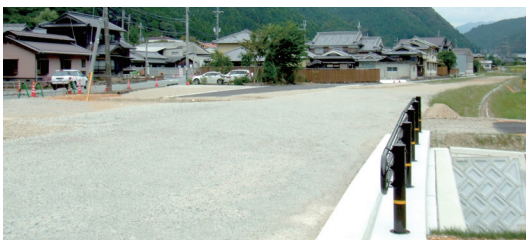
道路改良 加美八千代線 天船バイパス
